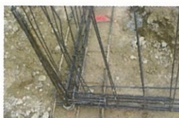
Noeud de chaînage - Continuité mécanique
